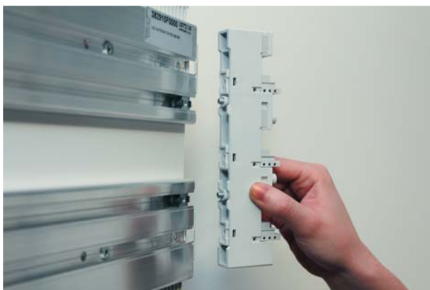
Schritt 3: Wenn beide Gleitmutter an der gewünschten Stelle platziert wurden, kann die Komponente dort angebracht werden.
