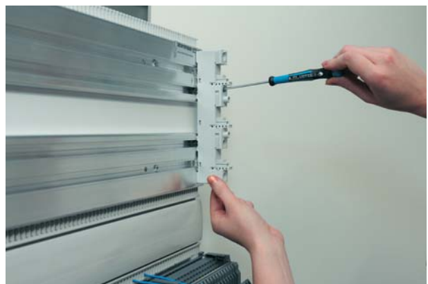
Schritt 4: Komponente ggf. ausrichten und einfach befestigen.
