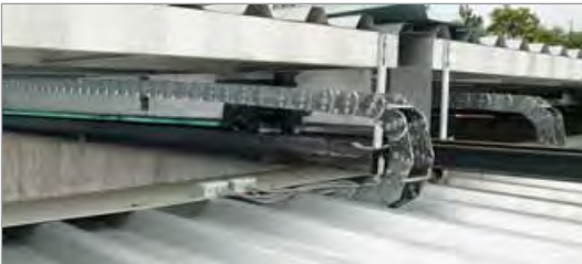
Energieführungsketten aus Stahl an einer verfahrbaren Dachkonstruktion Fotos: Lindenschmidt KG
