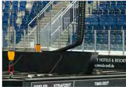
Energieführung UNIFLEX in Zick-Zack-Ablage am abenskbaren Multimedaiwürfel in der Arena – Nürnberg
